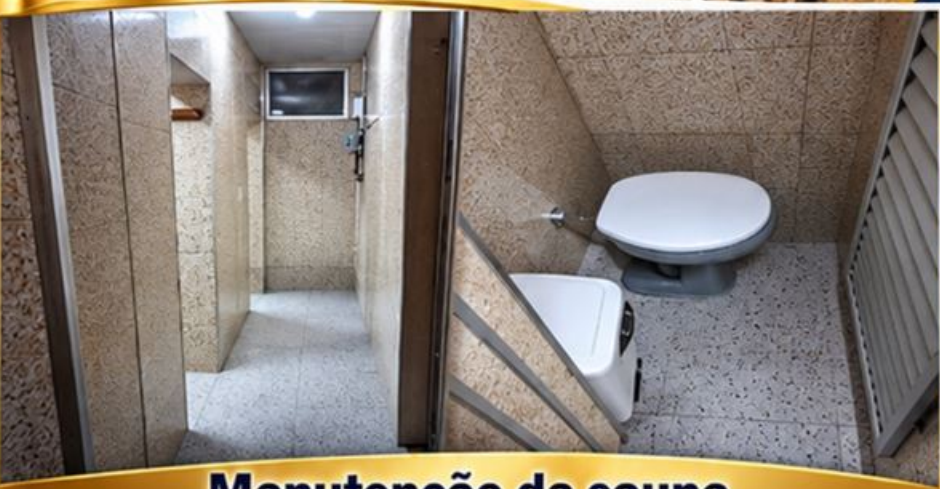
Manutenção da sauna
